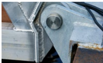
Scharnier toegangsbrug
